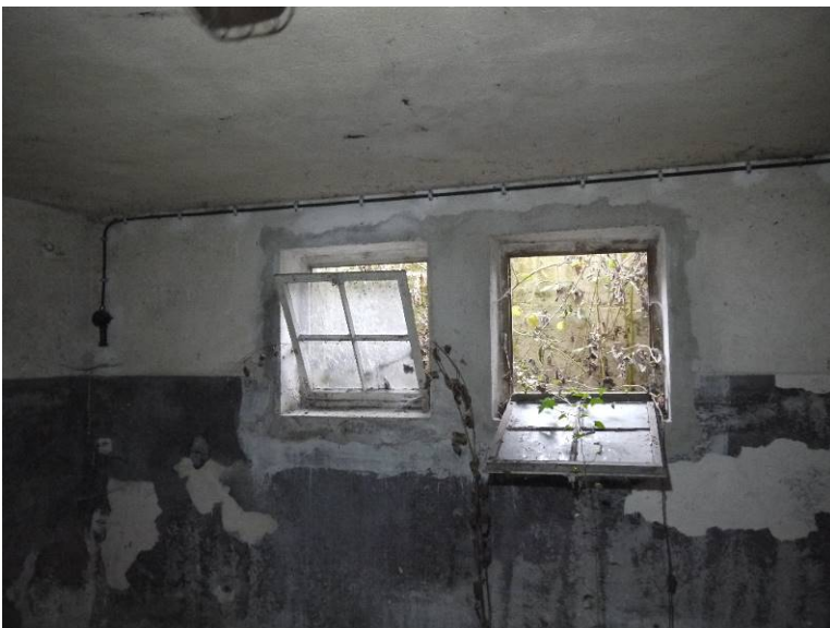
Abb. 3: Zugang in den Keller über offene Kellerfenster.
