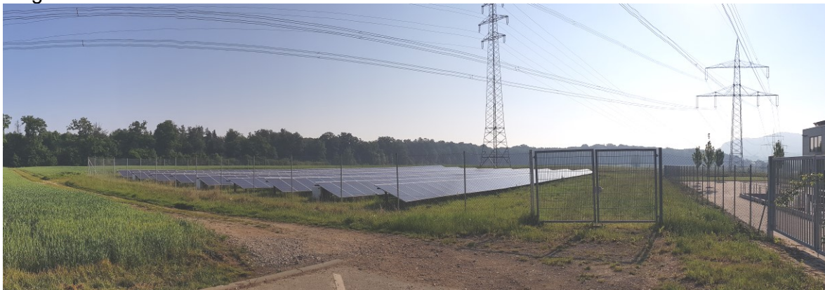
Abb.: bestehende Freiflächenphotovoltaik-Anlage
