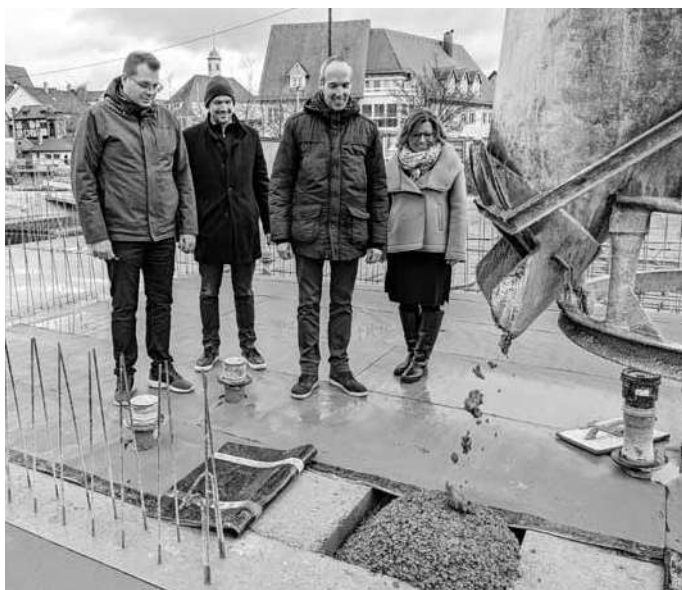
Einbetonieren der Zeitkapsel im Fundament der neuen Schulturnhalle.
