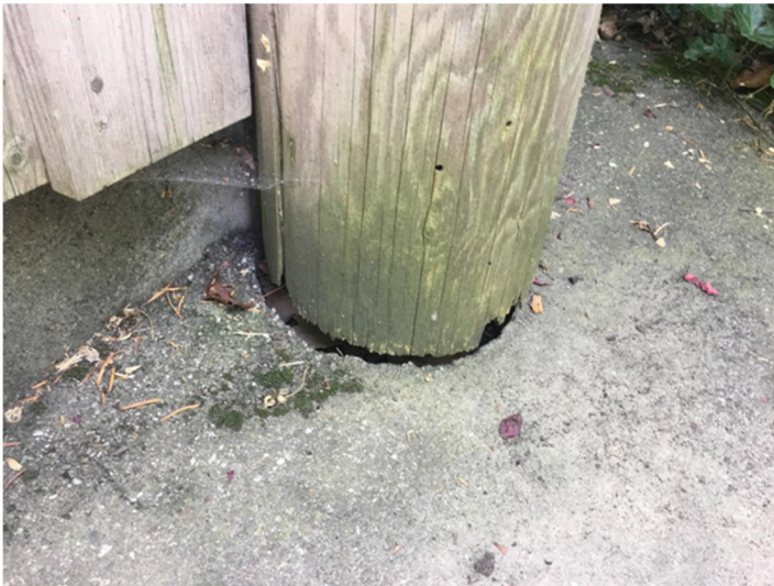
Standpfosten durchgefaut Standicherheit nicht gewährleistet
