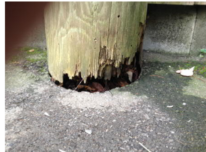
Standpfosten durchgefaut Standicherheit nicht gewährleistet
